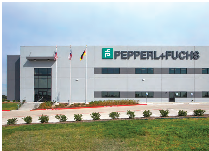
Рис. 1. Здание распределительного склада Pepperl+Fuchs в Северной Америке
