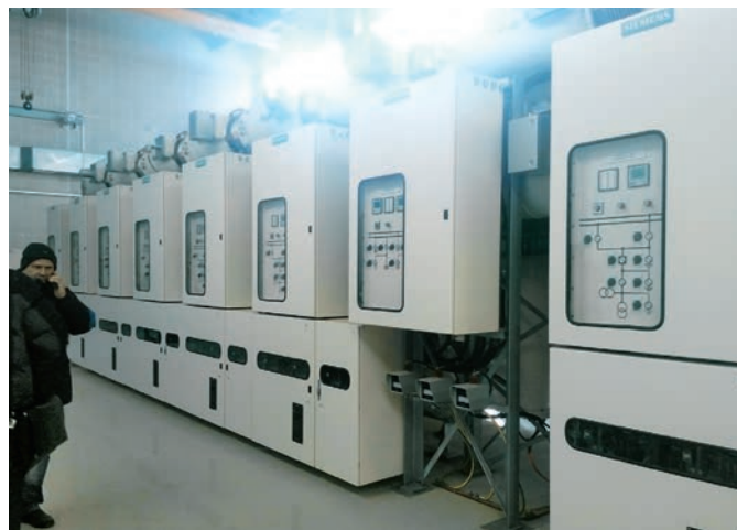
Рис. 2. Комплектное распределительное устройство (КРУЭ)
