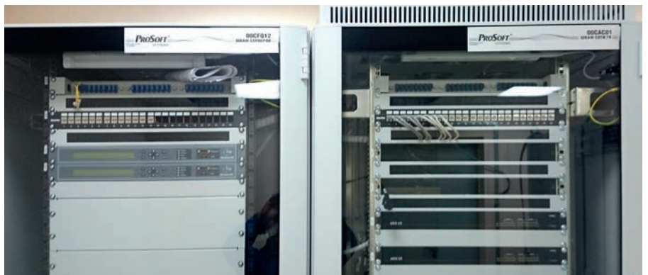
Рис. 5. Основное оборудование СОТИ АССО, шкаф серверов
