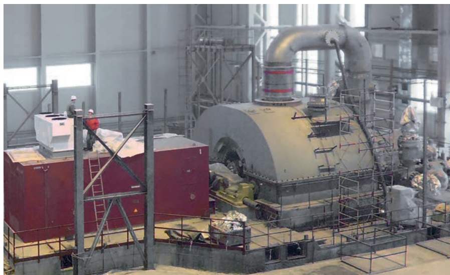
Рис. 1. Парогазовая установка ПГУ-410Т
