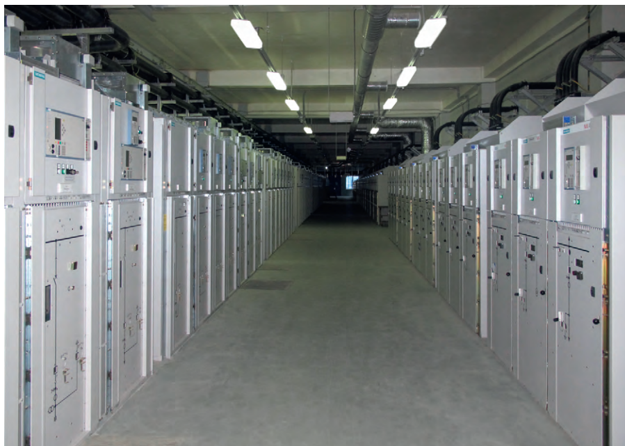
Рис. 6. Подстанция ПГВ-2, закрытые распределительные устройства 6 кВ
