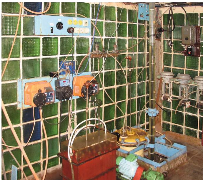
Рис. 6. Насосы-дозаторы
