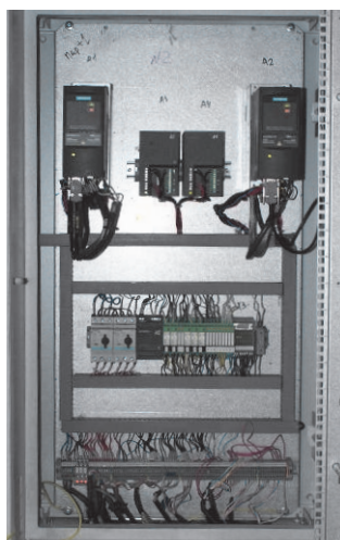
Рис. 3. Шкаф управления электроприводом
