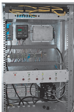
Рис. 4. Шкаф контроллера управления и дополнительных устройств
