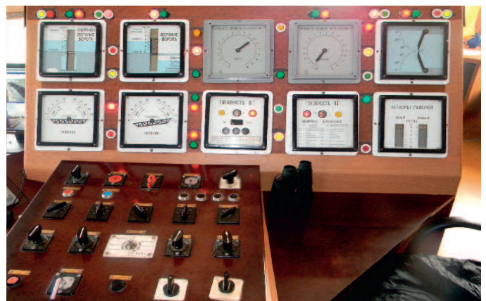
Рис. 7. Штатный пульт управления шлюзом в башне ЦПУ
