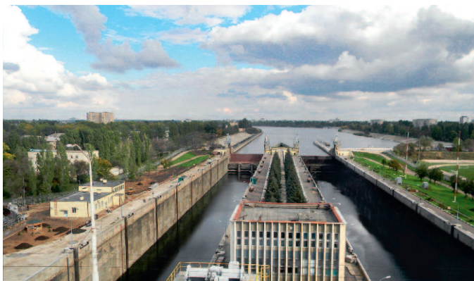
Рис. 3. Вид на шлюзы с поста управления
