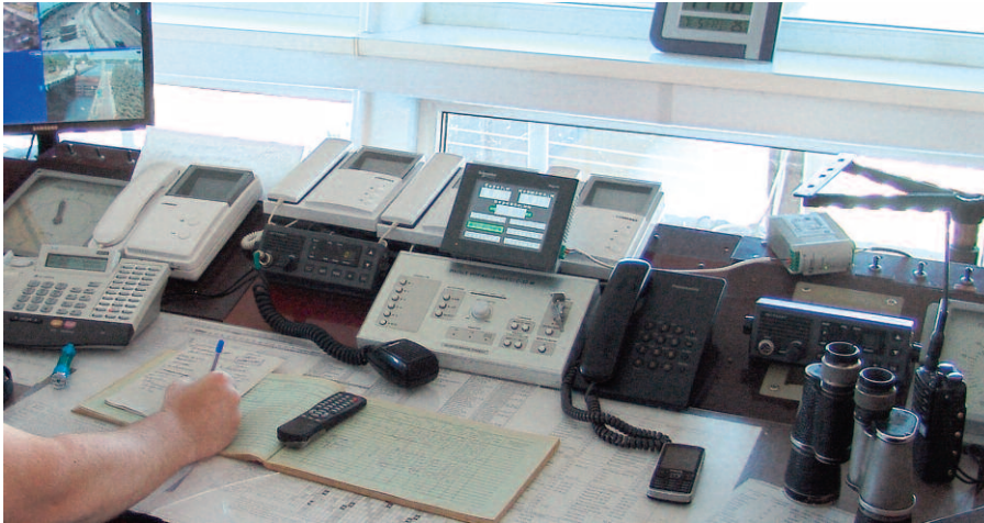
Рис. 8. Панель оператора в ЦПУ шлюза
