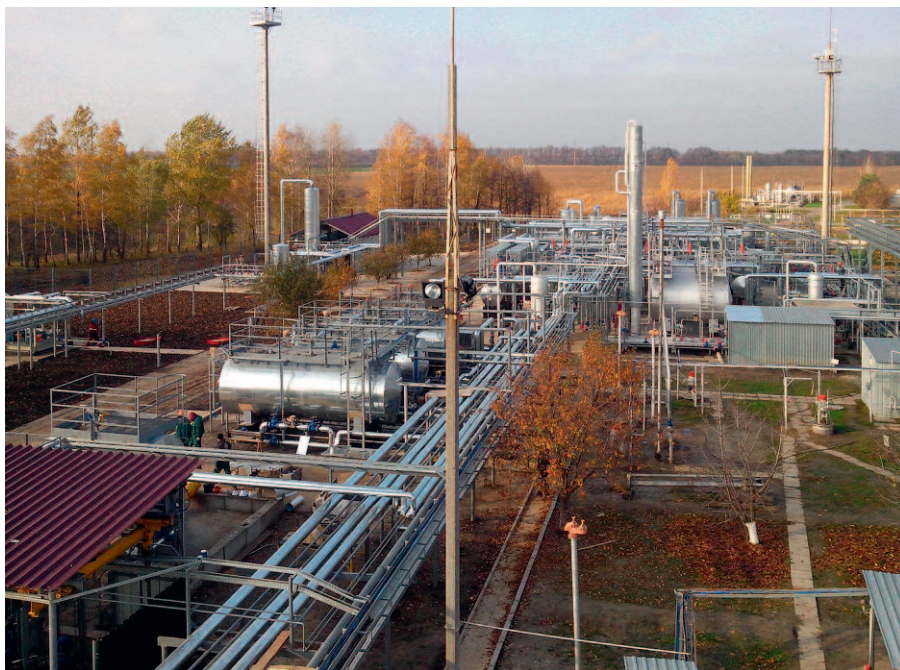
Рис. 2. Установка комплексной подготовки газа
