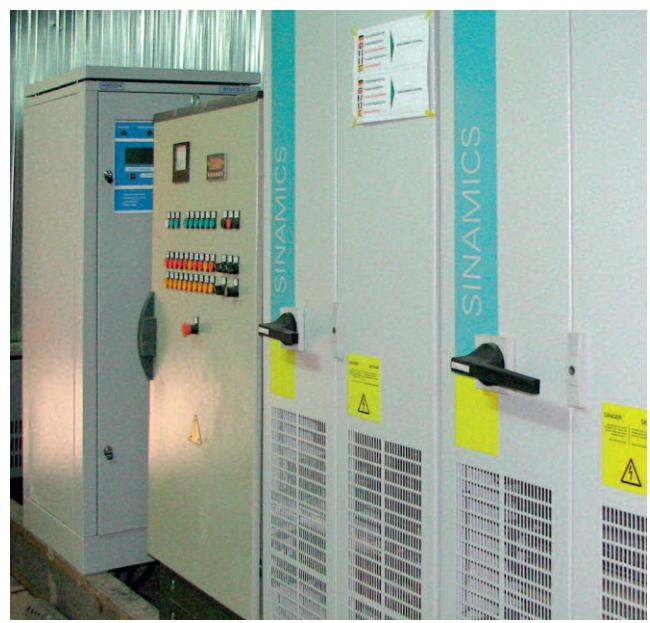
Рис. 4. Частотные приводы большой мощности SINAMICS
