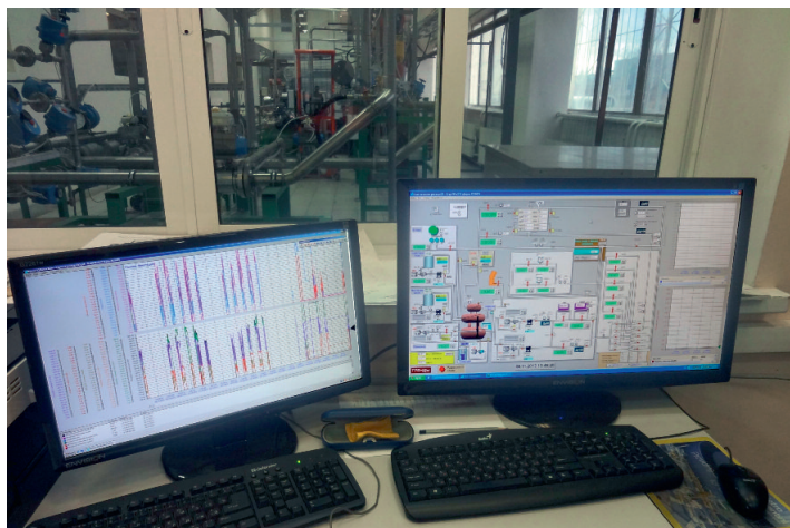
Рис. 7. Автоматизированные рабочие места операторов
