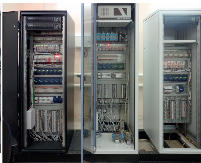
Рис. 6. Внешний вид контроллерных шкафов
