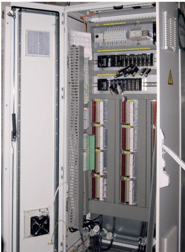
Рис. 1. Контроллер CJ1G, размещённый в шкафу на ТЭЦ
