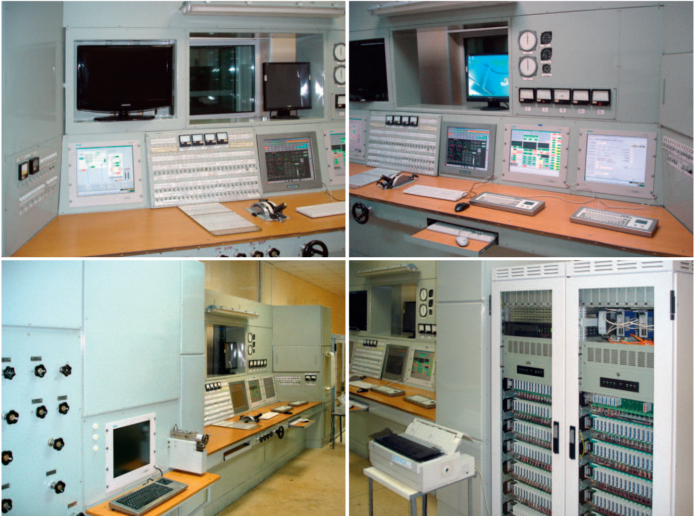
Внешний вид кабины наблюдения испытательного стенда
