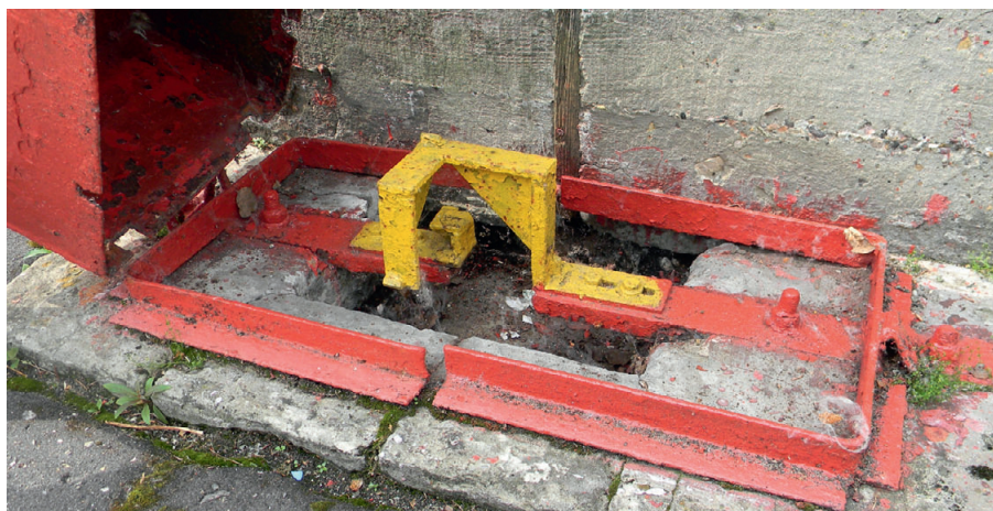
Рис. 1. Измерительная часть щелемера
