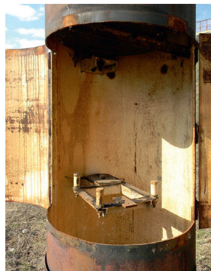
Рис. 2. Обратный отвес с оборванной нитью
