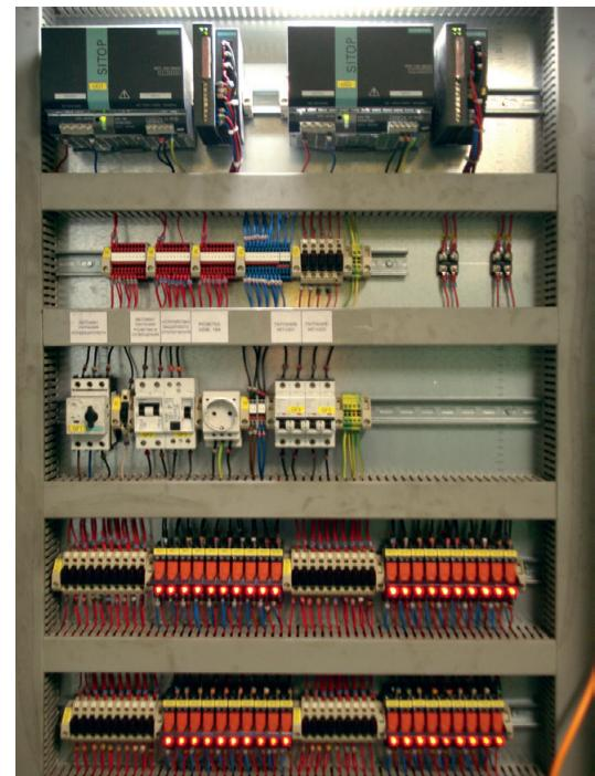
**Рис. 3. Аппаратные средства среднего уровня системы управления размещены в специализированных шкафах фирмы Rittal со степенью защиты IP54**
