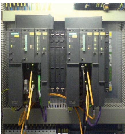
Рис. 4. Дублированный контроллер S7-400
