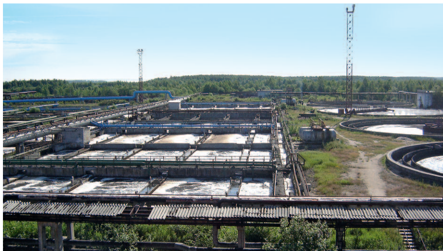
Рис. 1. Общий вид территории станции биологической очистки
