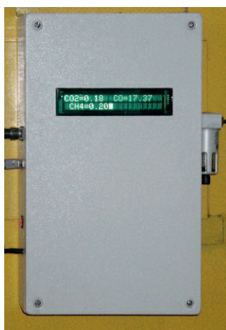
Рис. 3. Электронное табло на панели шкафа управления
