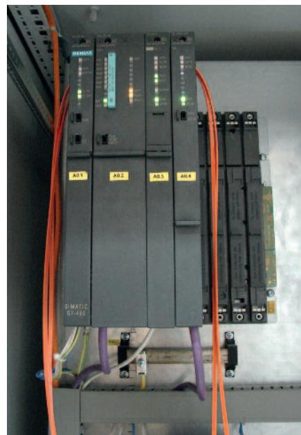
Рис. 5. Программируемый логический контроллер системы МПЦ
