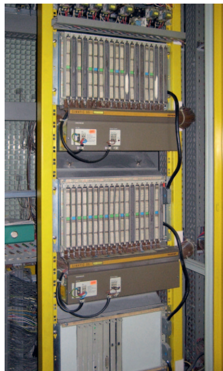
Рис. 1. Стойка контроллера (внизу) и стойки расширения 1 и 2
