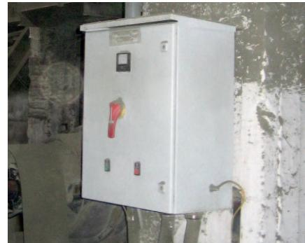
Рис. 9. Местный выключатель безопасности
