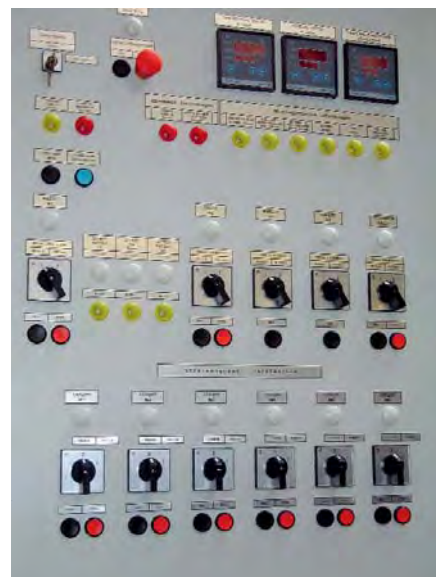
Рис. 10. Шкаф ШУ1-МГ: органы управления и сигнализации
