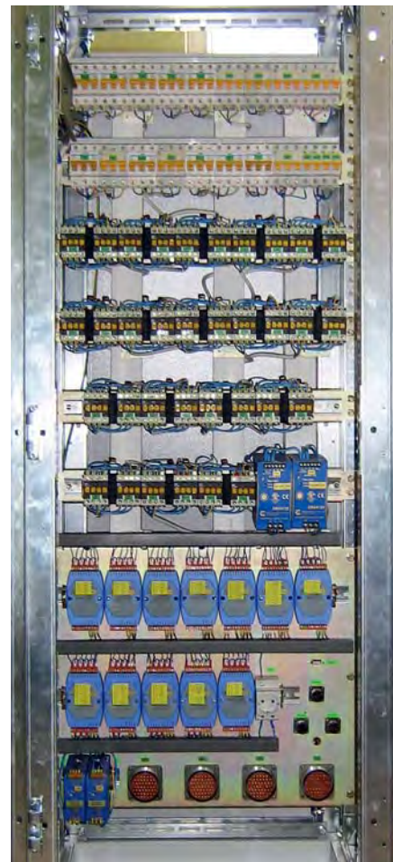
Рис. 7. Шкаф с силовой и коммутационной аппаратурой
