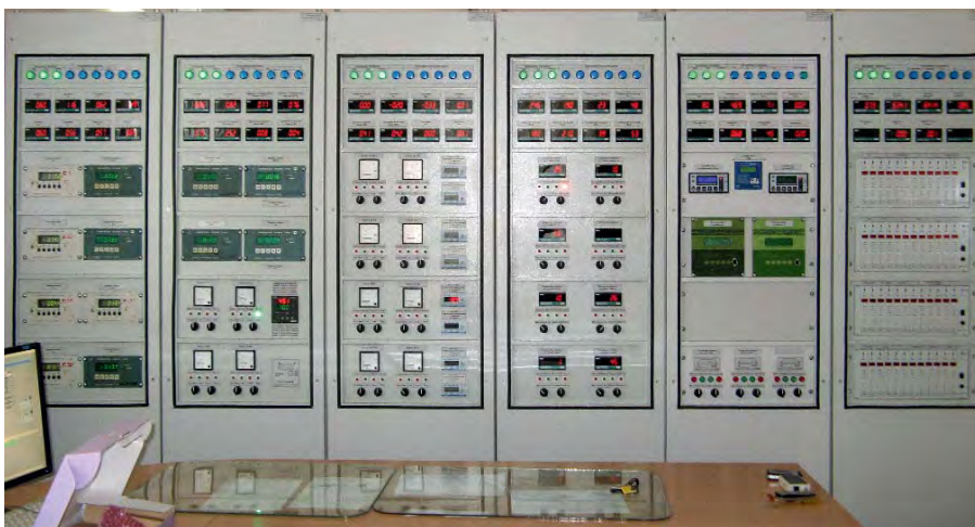
Рис. 2. Операторная ДНС Западно-Бурейкинского месторождения
