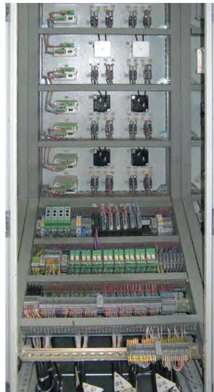
Рис. 4. Секция контроля и управления электродвигателями
