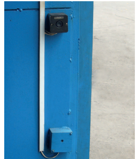
Рис. 4. Приёмник ИК-излучения в защитной металлической коробке и кнопка местного управления
