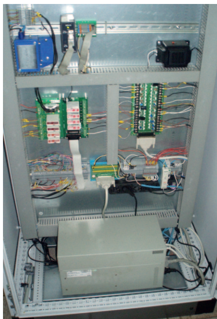
Рис. 1. Оборудование щита управления варочного отделения
