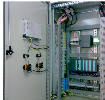
Рис. 2. Контроллер SIMATIC S7-300 в шкафу управления
