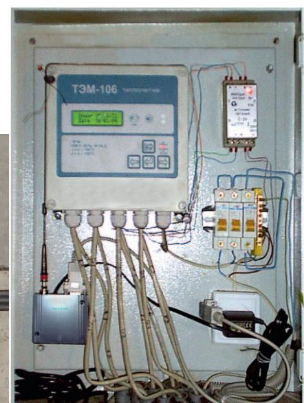
Рис. 2. Фрагмент системы: подключение теплосчётика и шкаф с теплосчётиком и модемом
