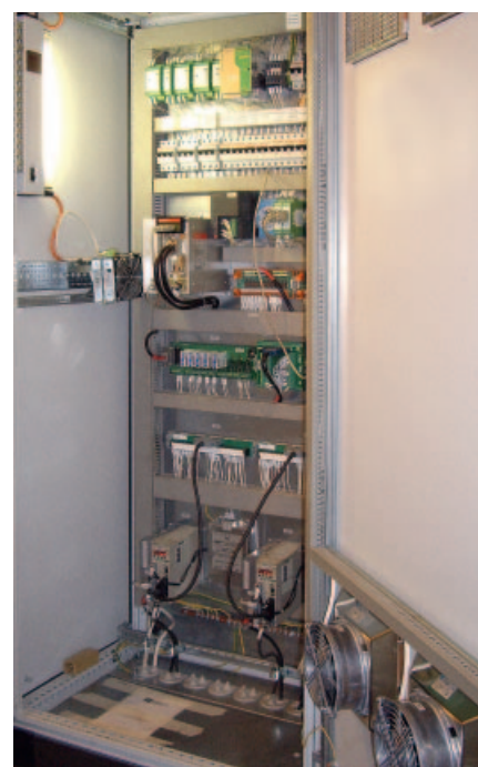
Рис. 6. Щит системы управления
