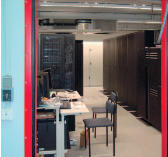
Рис. 1. Интерьер модульной комнаты безопасности Lampertz
