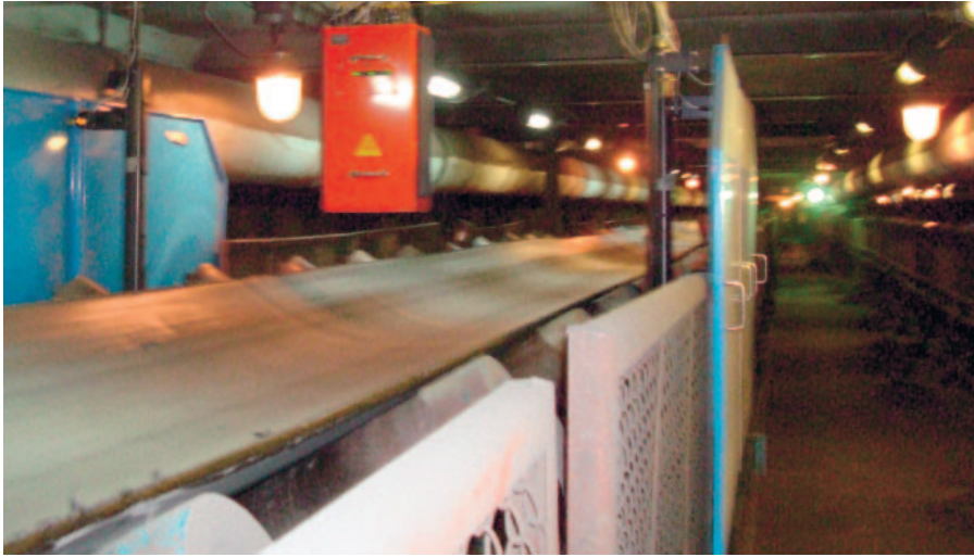
Рис. 3. Рудоконтролирующая станция, установленная на конвейере
