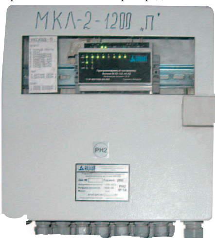
Рис. 2. Устройство контроля состояния концевых выключателей и датчиков
