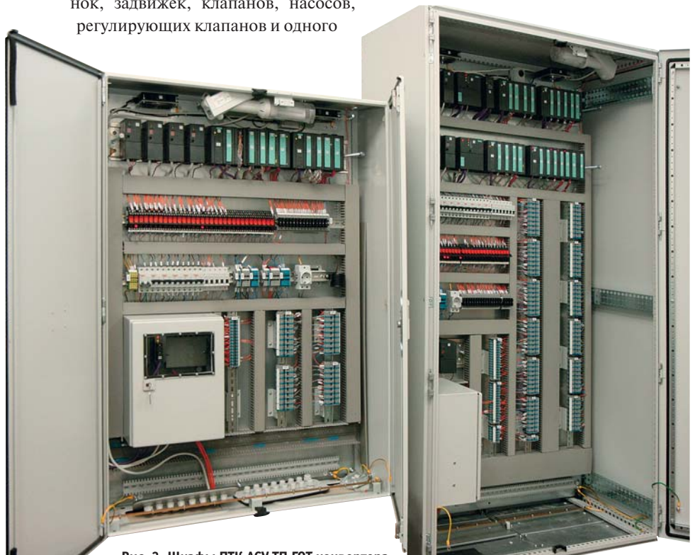
Рис. 3. Шкафы ПТК АСУ ТП ГОТ конвертера
