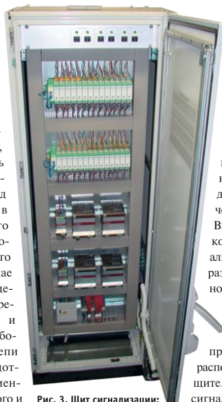
Рис. 3. Щит сигнализации: конструктивное размещение элементов
