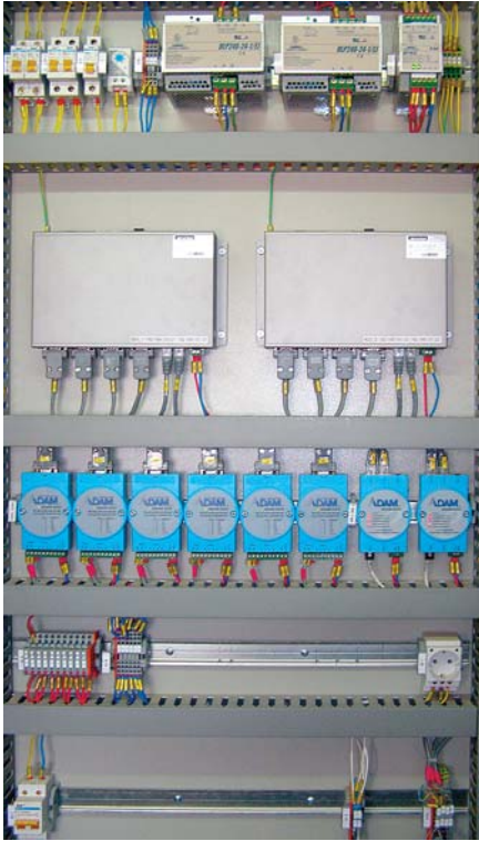
Рис. 3. Шкаф контроллеров и средств коммуникаций
