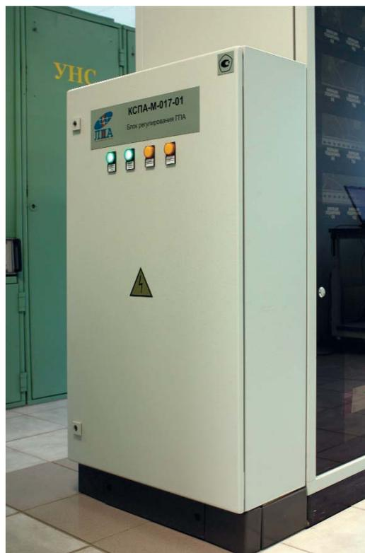
Рис. 4. Блок регулирования ГПА разработки и производства НПК «ЛЕНПРОМАВТОМАТИКА»
