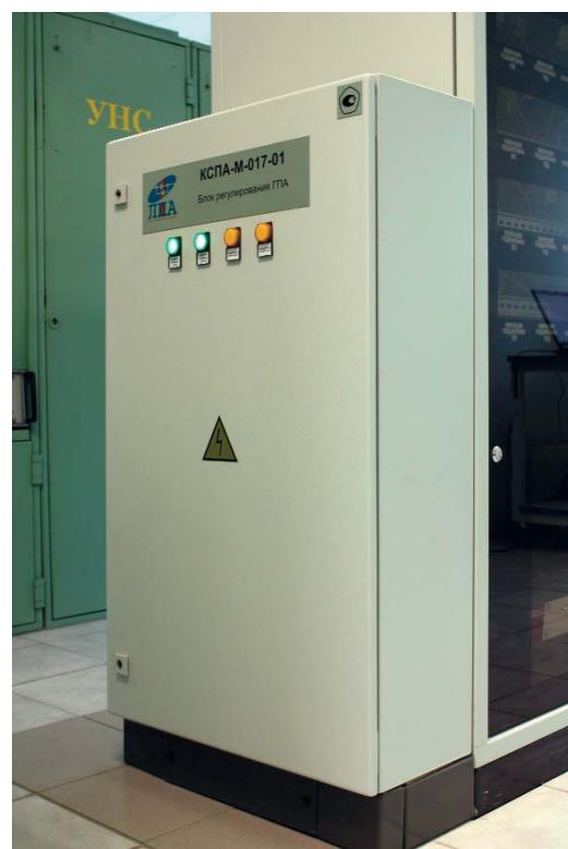
**Рис. 4. Блок регулирования ГПА разработки и производства НПК «ЛЕНПРОМАТОМАТИКА»**
