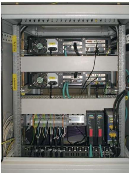
Рис. 3. Стойка системных блоков АРМ ДСП (вид сзади)
