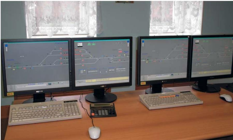
Рис. 1. Автоматизированное рабочее место дежурного по станции (основное и резервное)
