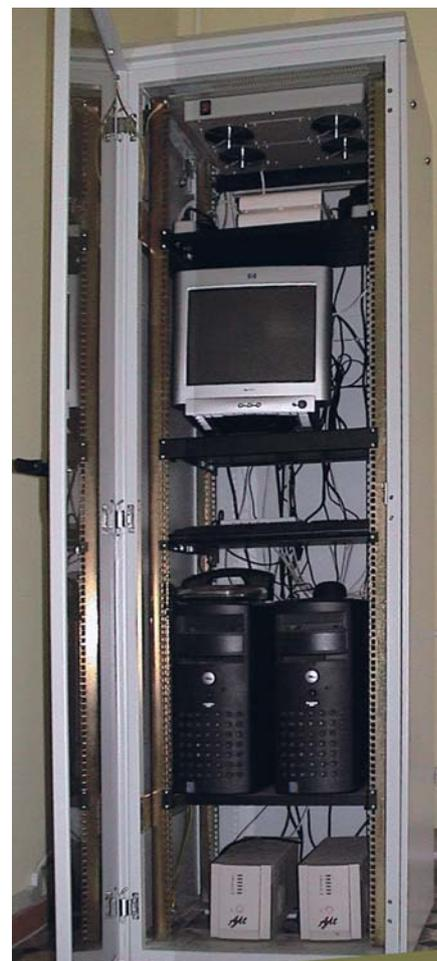
Рис. 6. Серверная стойка центрального диспетчерского пункта
