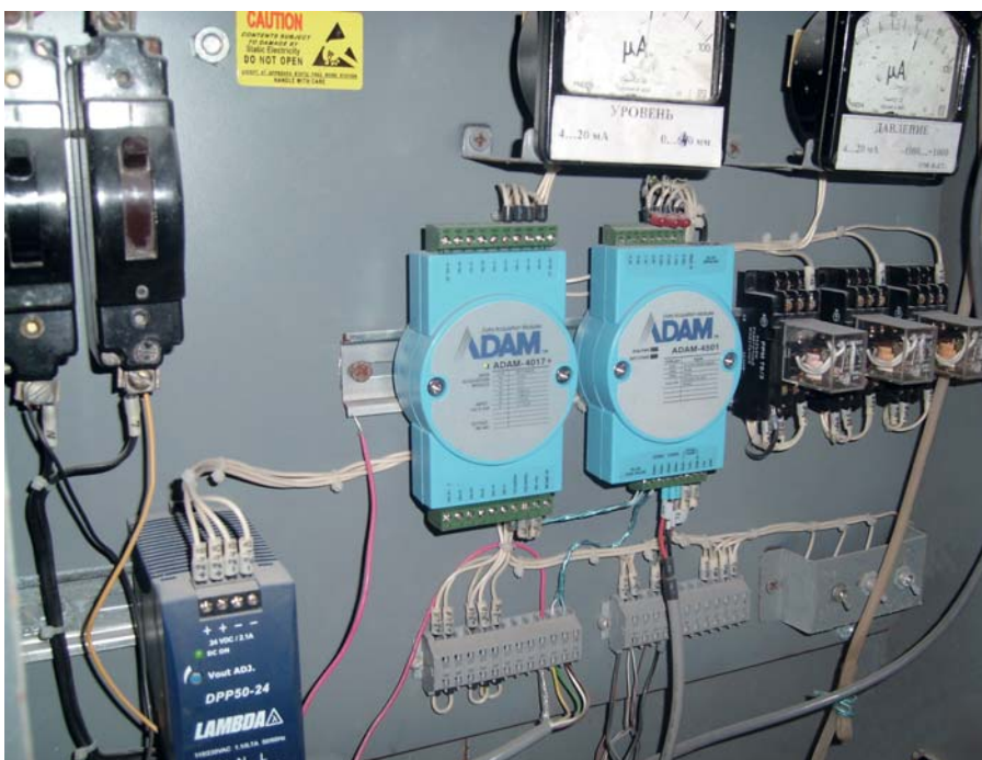
Рис. 7. Внешний вид приборов шкафа КИП
