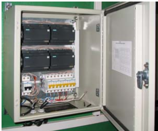
Рис. 7. Монтаж блока БП-240
