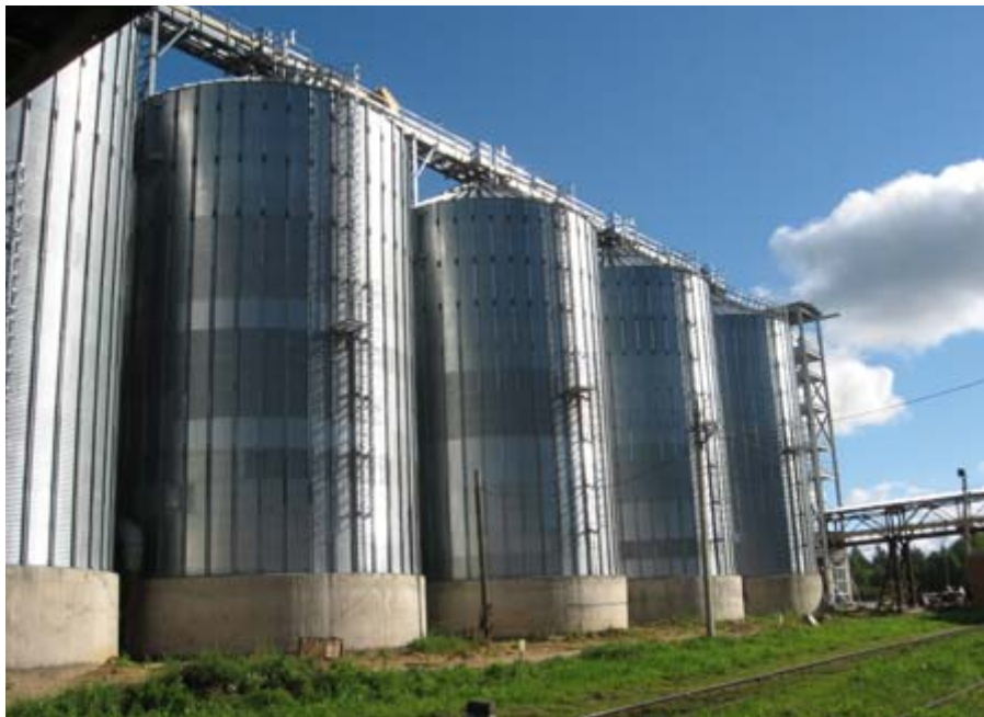
Рис. 1. Силосный корпус элеватора
