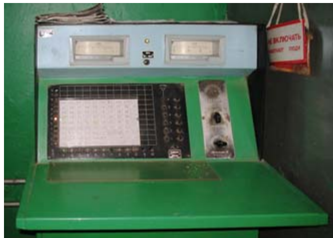
Рис. 2. Пульт управления устаревшей системы ДКТЭ-4М
