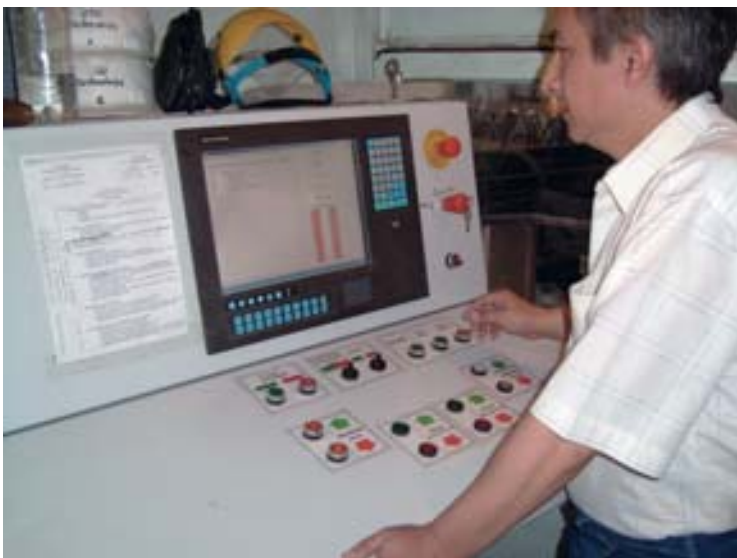
Рис. 9. АРМ оператора с пультом управления и рабочей станцией
