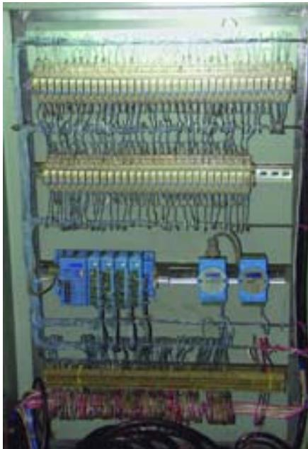
**Рис. 5. Общий вид шкафа контроллера смесильной машины**
