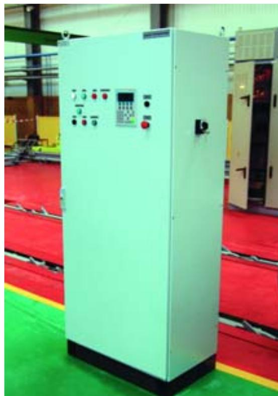
Рис. 6. Щитовое электрооборудование подсистемы № 11
