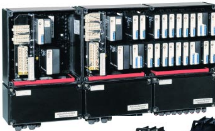
Рис. 7. Внешний вид подстанции системы FB
