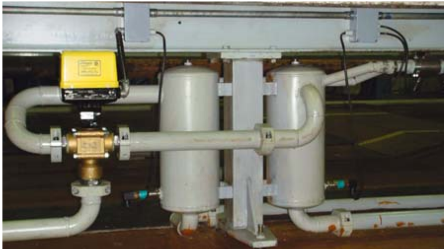
Рис. 2. Ресиверы масла и тосола с сигнализаторами уровня и воздушными клапанами
