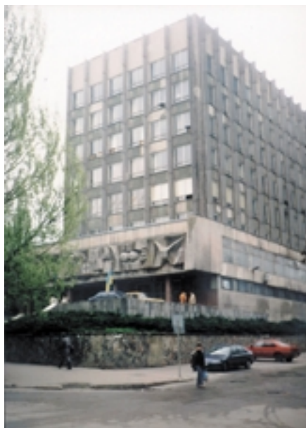
Здание электротехнического факультета ДонГУ
