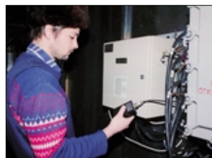
Рис. 5. ИВУ стационарной системы «Поток-3М» в блок-боксе
