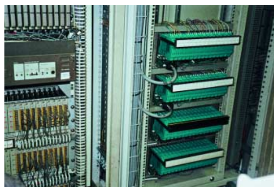
Разделительные модули К-системы, установленные в шкафу диспетчерской
