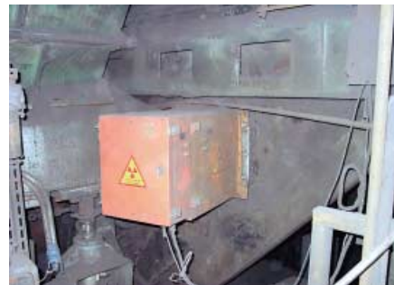
Рис. 2. Установка датчика в весовой воронке доменной печи
