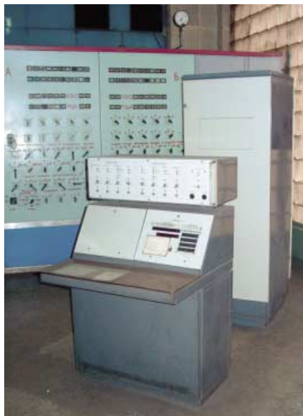
Рис. 4. Пульт управления системой, введённой на доменной печи № 2 ОАО «Испат-Кармет»
