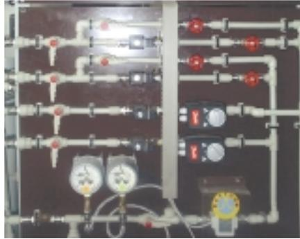
Рис. 13. Гидропанель ввода воды
