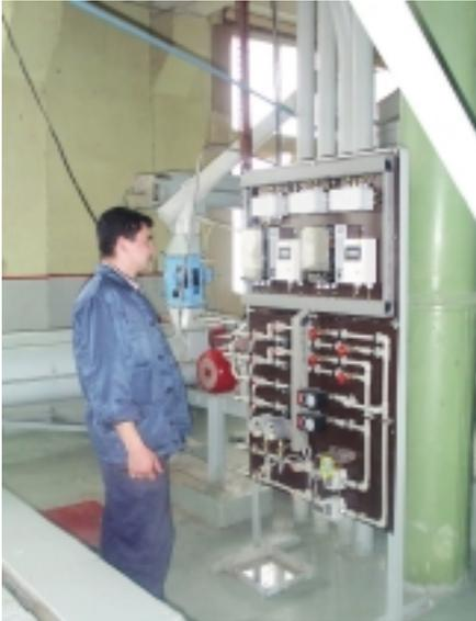
Рис. 2. Панель вторичных приборов и гидрпанель
