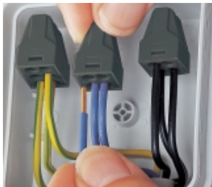
Рис. 5. Быстрый и простой монтаж с помощью клемм WAGO
