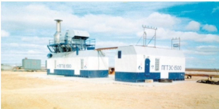
Рис. 1. Электростанция ПГТЭС-1500 в районе Нового Уренгоя
