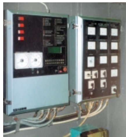
Рис. 5. ПУД и ПУГ в блоке управления электростанции
